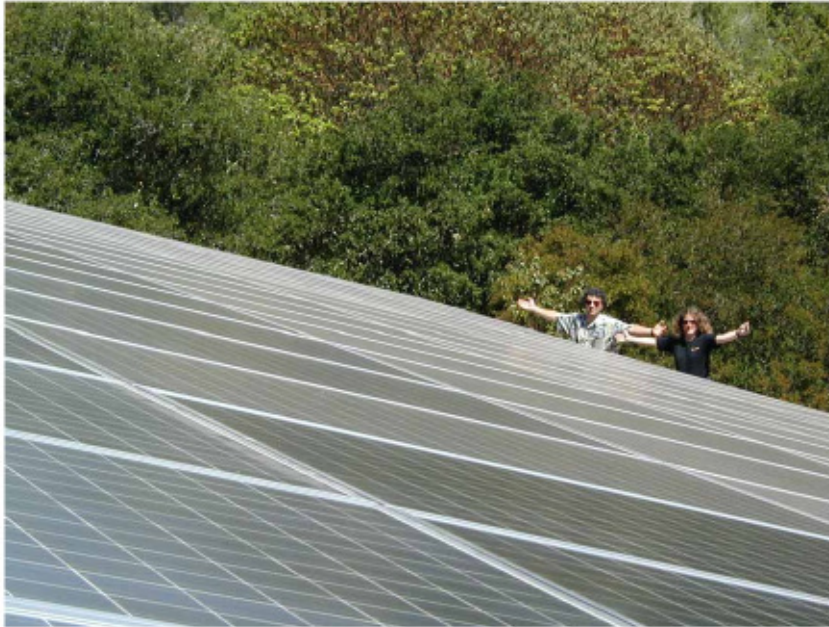
Fig.6.6: zwei Sonnenkämpfer genießen ihre PV-Anlage, die ihre Elektroautos und ihr Heim versorgt. Das Feld aus 120 Modulen (jedes 300 W bzw. 2,2 m 2 ) hat insgesamt eine Fläche von 268 m 2 , einen Spitzen-Output (vor Wechselrichter-Verlusten) von 30,5 kW und einen mittleren Output – in Kalifornien nahe Santa Cruz – von 5 kW (19 W/m 2 ). Foto mit freundlicher Genehmigung von Kenneth Adelman www.solarwarrior.com
