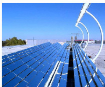
Fig.6.19: eine kombinierte Wärme-und-Strom-Solaranlage von Heliodynamics. Eine Reflektorfläche von 32 m^2 (etwas größer als die Seite eines Doppeldeckerbusses) liefert bis zu 10 kW Wärme und 1,5 kW Elektrizität. In einem sonnigen Land könnte eines dieser etwa eine Tonne schweren Geräte 60 kWh/d Wärme und 9 kWh/d Elektrizität produzieren. Das entspricht (pro qm Geräteoberfläche) mittleren Flüssen von 80 W/m^2 Wärme und 12 W/m^2 Strom. Diese Flüsse sind vergleichbar mit denen aus Standardgeräten zur solaren Heizung und PV-Modulen, doch dieses Konzept von Heliodynamics liefert die Leistung zu geringeren Kosten, denn das meiste Material ist nur einfaches Glas. Zum Vergleich: mittlerer Energiebedarf eines Europäers: 125 kWh/d.
