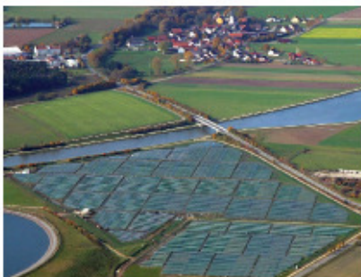
Fig.6.7: Eine PV-Freiflächenanlage mit 6,3 MW (peak), der Solarpark in Mühlhausen, Bayern. Die mittlere Leistung pro Landflächeneinheit dürfte um die 5W/m 2 liegen. Foto: SunPower.
