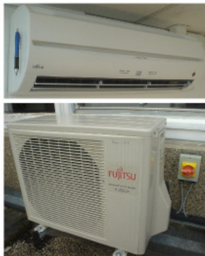
Fig.21.11: Das innere und das äußere Bauteil Luftwärmepumpe mit einer Leistungszahl von 4. Am inneren ist ein Kugelschreiber als Größenvergleich angebracht. Eine dieser Fujitsu-Maschinen kann 3,6 \text{ kW} Heizleistung mit 0,845 \text{ kW} elektrischer Leistung liefern. Sie kann auch umgekehrt laufen und liefert dann 2,6 \text{ kW} Kühlleistung mit 0,655 \text{ kW} Elektrizität.
