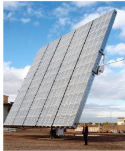
Fig.25.9: Ein 25 \text{ kW} (peak) PV-Kollektor mit Lichtbündelung des kalifornischen Herstellers Amonix. Eine 225 \text{ m}^2 Lichtfläche enthält 5760 Fresnellinsen mit einer optischen Konzentration von \times 260 , von denen jede eine 25\% -effiziente Siliziumzelle beleuchtet. In einer geeigneten Wüstengegend liefert dieser Kollektor 138 \text{ kWh} pro Tag, genug für den Energiekonsum eines halben Amerikaners. Beachte den Menschen als Größenvergleich. Foto von David Faiman.
