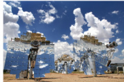
Fig.25.3: Stirling-Maschine. Diese formschönen Reflektoren liefern eine Leistungsdichte pro Landfläche von 14 W/m 2 . Foto mit freundlicher Genehmigung von Stirling Energy Systems. www.stirlingenergy.com
