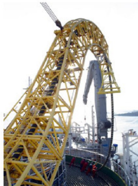
Fig.25.7: Verlegen eines HVDC Kabels zwischen Finnland und Estland. Ein solches Kabelpaar überträgt 350 MW Leistung. Foto: ABB
