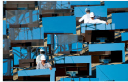
Fig.25.12: Zwei Ingenieure bauen ein eSolar-Kraftwerk mit Heliostaten (Spiegel, die sich drehen und neigen können um der Sonne zu folgen) auf. esolar.com stellt mittelgroße Kraftwerke her: eine 33MW(peak) Anlage auf 64 Hektar. Das sind 51 W/m 2 (peak), in typischer Wüstenlage könnten, würde ich schätzen, etwa 25% davon als Dauerleistung geliefert werden: 13 W/m 2 .
