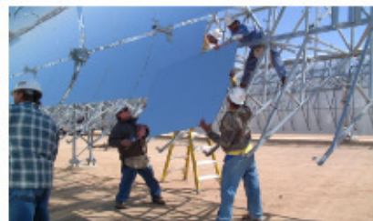
Fig.25.4: Andasol, Spanien - ein „100MW“ Solarkraftwerk in Bau. Übrige thermische Energie, die tagsüber produziert wird, wird in Flüssigsalztanks bis zu sieben Stunden gelagert, was eine kontinuierliche und stabile Netzversorgung gewährleistet. Das Kraftwerk soll voraussichtlich 350 GWh im Jahr (40 MW) liefern. Die Paraboltröge belegen 400 Hektar, die Leistungsdichte pro Landfläche ist also 10 W/m 2 . Foto oben: ABB, Foto unten: IEA SolarPACES.
